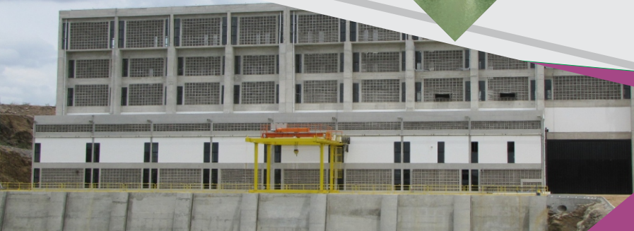
Estação de Bombeamento EBI-1
